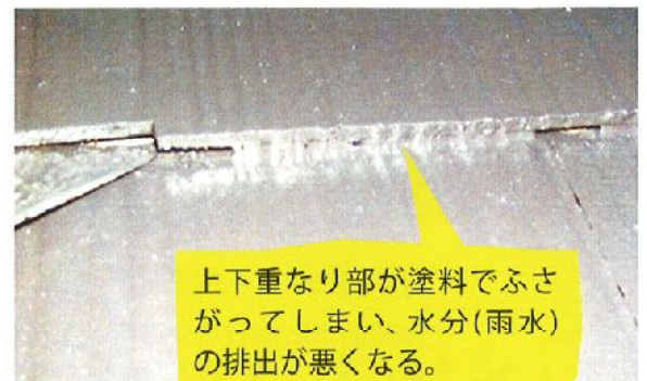
● 試験塗装の様子
